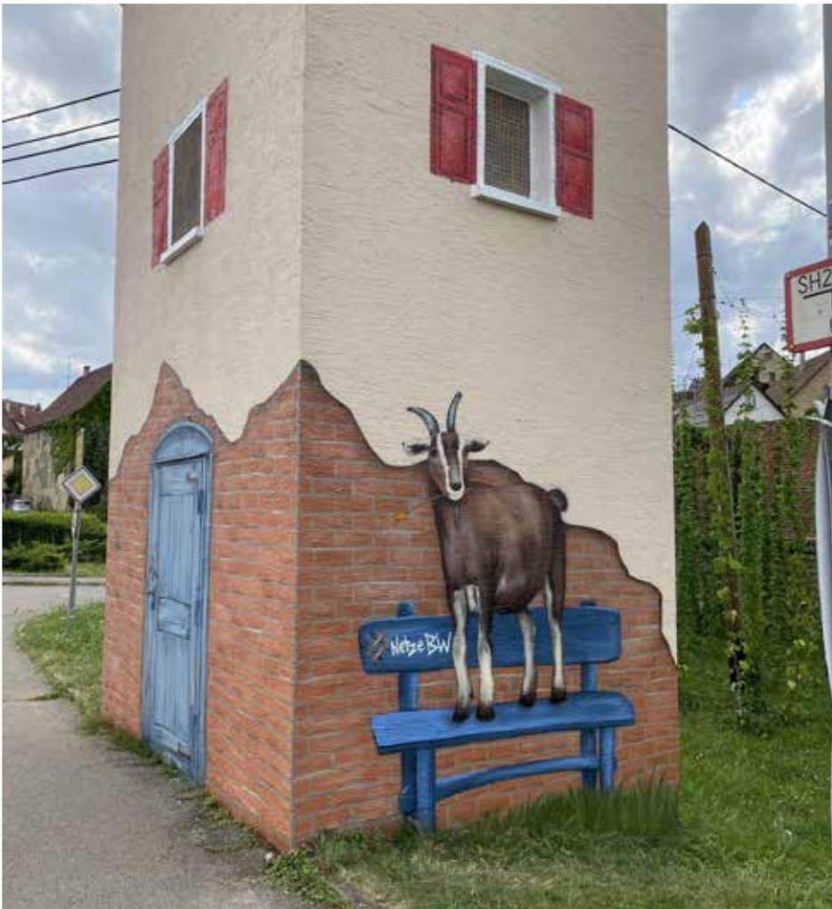
**Munderkingen.** Ortsnetzstation, Umspannstation oder einfach nur Trafohäuschen – unterschiedliche Bezeichnungen für dieselbe Sache: Sie alle beschreiben eine technische Anlage, die den Strom von Mittel- auf Niederspannung umwandelt und die Endverbraucher mit haushaltsüblichen 400 Volt versorgt. Den Begriff des Kunstwerks würde man hier eher nicht vermuten. Und dennoch trifft er bisweilen zu! So wie seit Kurzem in Munderkingen im Angerweg.
